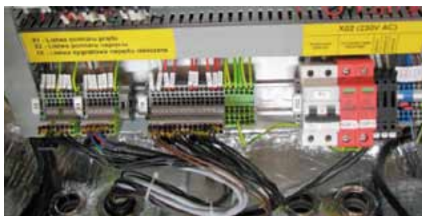
Fig. 9 Uscita del cavo di collegamento dall'unità di controllo SRC-1
